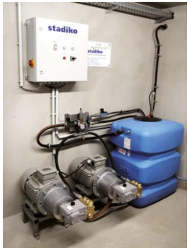
Doppelstufenanlage für zwei Anwender
