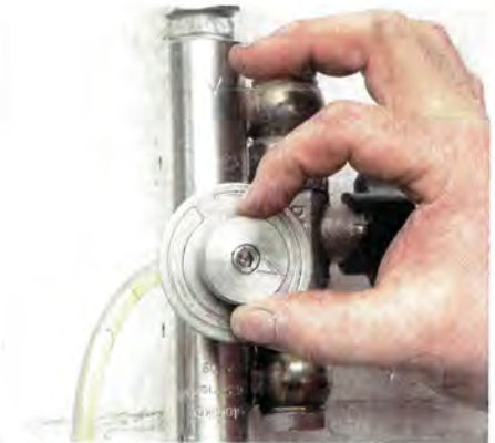
Das Einstellen der Dosierung ist mitunter schwierig und verlangt viel Erfahrung. Die Skalierung ist gut zu erkennen und langlebig.
