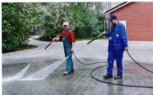
Roland Bley (links) und Christof Hanneken vom Betrieb Vossmann demonstrieren das Arbeiten mit dem Hochdruckreiniger (75 l/min., Einmannbetrieb; 36 l/min., Zweimannbetrieb)
