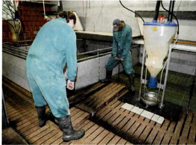
Am Ende wird der Boden wieder eingesetzt und die Stalleinrichtung zusammengebaut.
